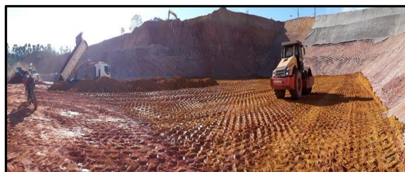
Impermeabilização de Fundo Coeficiente de Permeabilidade desejável
