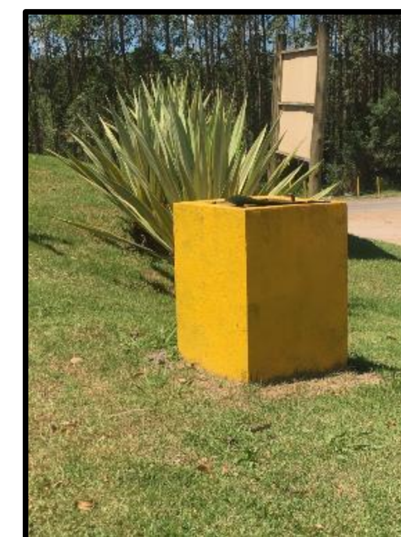
Poço de Monitoramento Água Subterrânea
