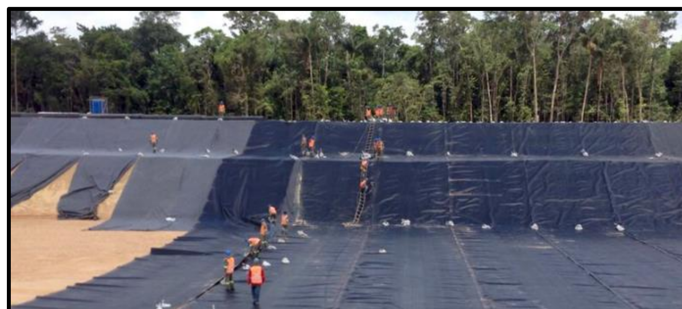
Instalação Geomembrana
