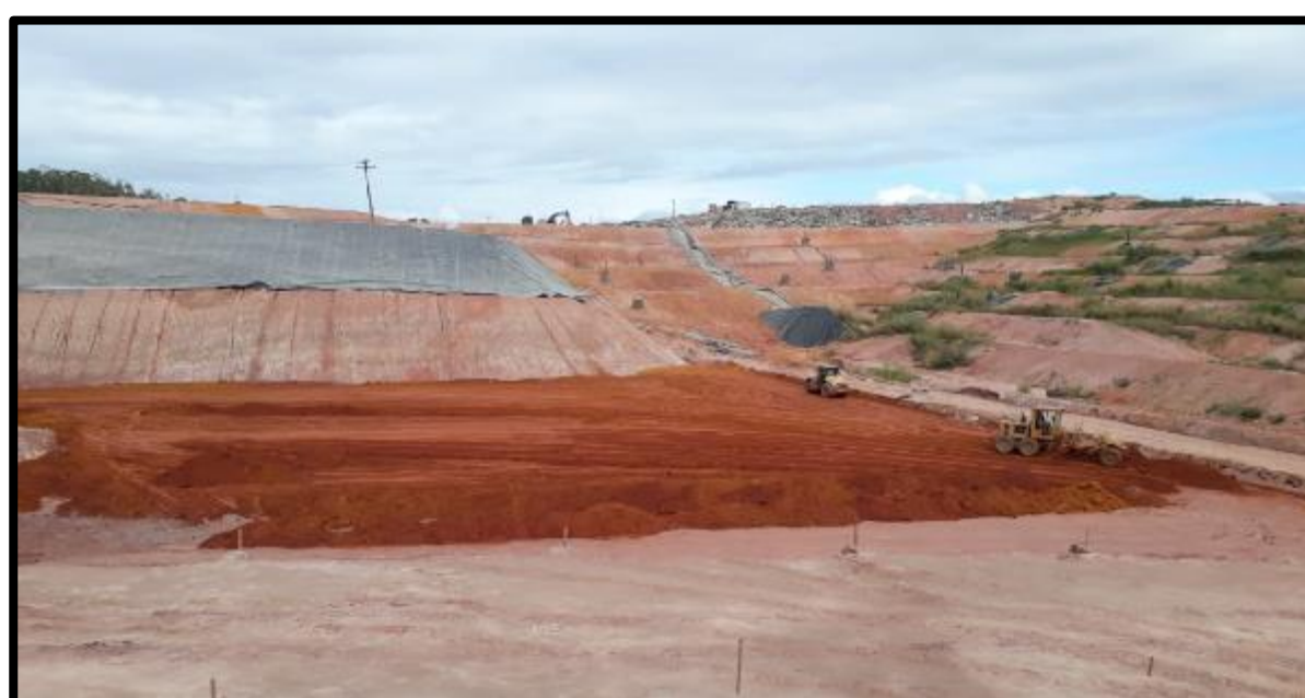
Nivelamento do Greide Projetado
