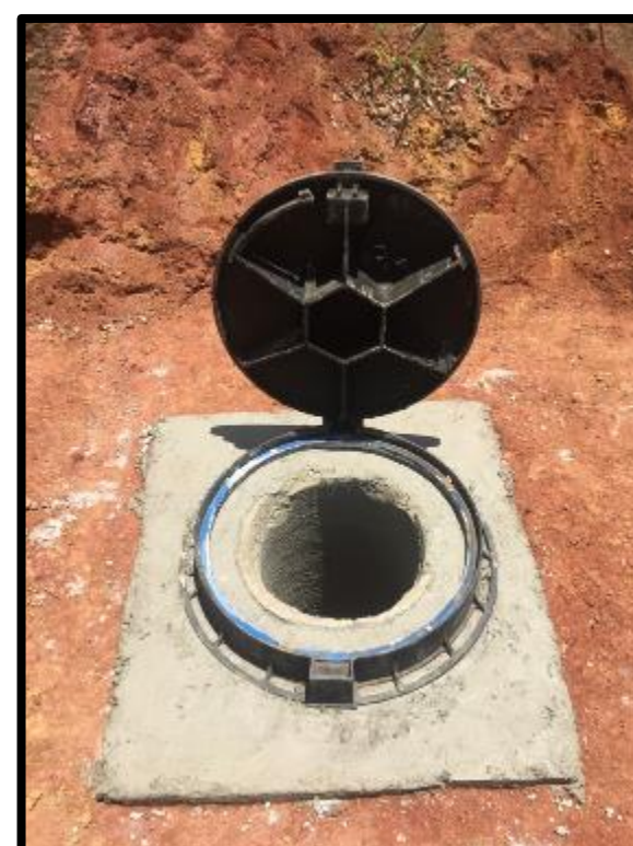
Inspeção Drenagem Testemunha
