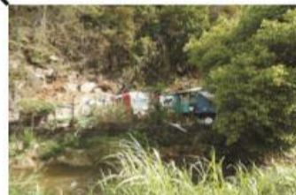
Casas em área de risco: inundação e escorregamento de encosta (solos e blocos de rocha)
