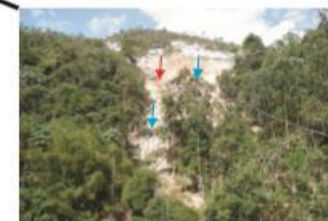
Movimentação de material na encosta, proveniente da atividade de extração (saibro) instalada no topo
